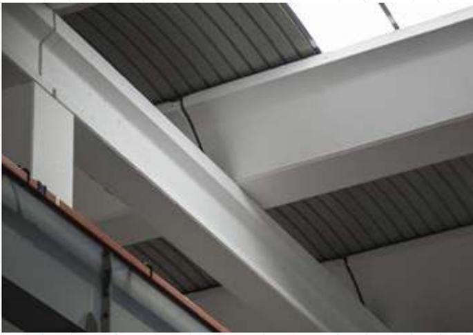
I tegoli con forma alare, se necessario, possono essere accostati, ovvero intervallati secondo richiesta, a interassi fino a 5 m di luce mediante l'installazione di coppelle in calcestruzzo, pannelli metallici monolitici precoibentati curvi o piani, lucernari zenitali o shed conferendo in questo modo all'edificio delle caratteristiche di elevata luminosità sia con incidenza zenitale che indiretta.
