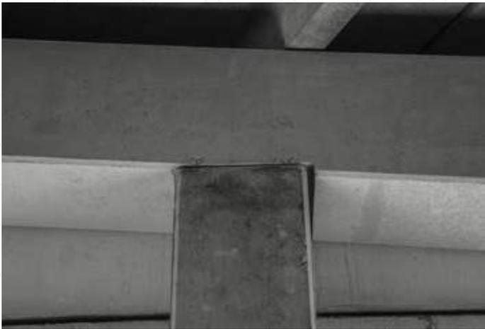
Le travi possono essere realizzate con diverse sezioni, larghezza dell'anima, sezioni delle ali. Allo stesso modo, i tegoli possono essere prodotti con diversa altezza e spessore della nervatura, al fine di consentirne l'impiego per la costruzione di edifici caratterizzati anche da elevati sovraccarichi, grandi luci e requisiti di resistenza al fuoco.
