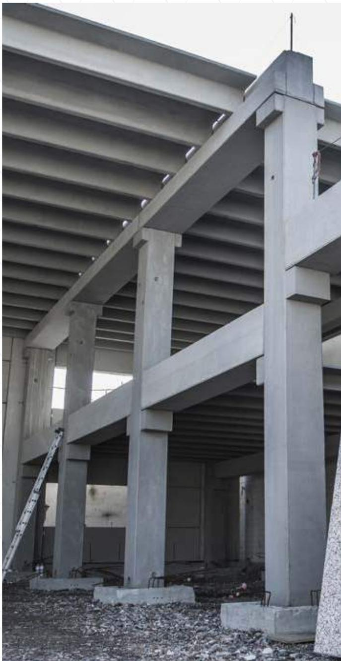
**MP Prefabbricati S.r.l.** dispone di un sistema produttivo di travi lineari e tegoli piani estremamente duttile, che permette di realizzare una vasta gamma produttiva in grado di incontrare i diversi requisiti in termini di sovraccarichi e destinazioni d'uso.
