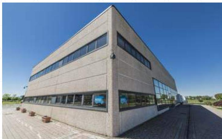
La struttura prefabbricata multipiano, benché basata sul solo impiego di travi lineari di differente sezione e di tegoli piani, consente di realizzare edifici pluripiano che possono soddisfare le necessità di diverse destinazioni d'uso.
