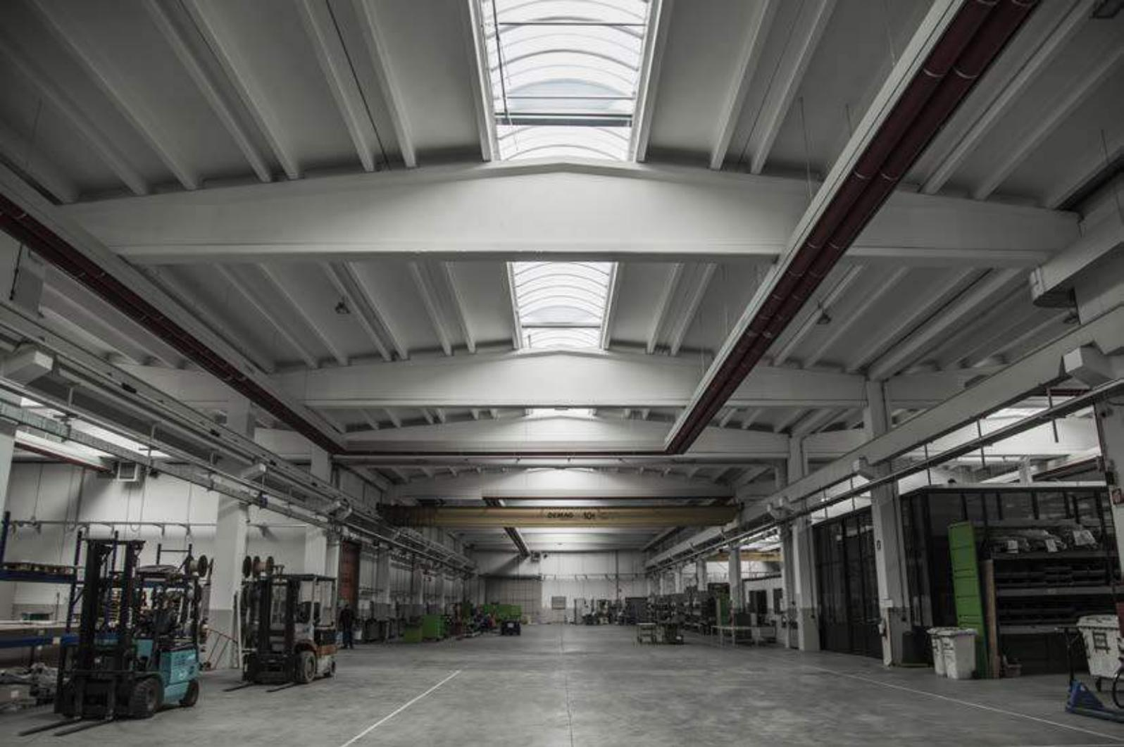
La versatilità della capriata in C.A.P. consente di inserire lucernari in falda e/o cupolini in colmo fissi o apribili, permettendo di ottenere una pregiata illuminazione dei locali sia diretta che indiretta senza dover ricorrere al supporto di corpi luce artificiali.
